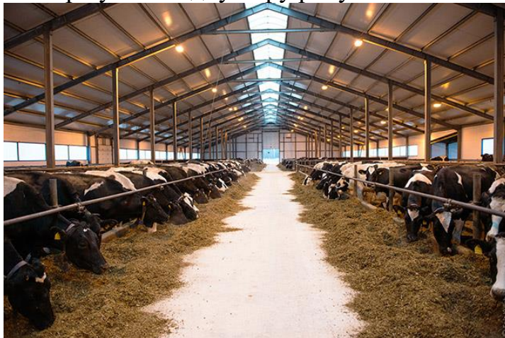
Рисунок 1 – Світло-аераційний коник і вентиляційні штори корівника
