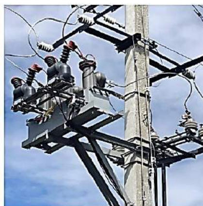
Рисунок 1 – Приклад застосування реклоузерів виробництва E.NEXT (а) в мережах енергопостачання 6(10) кВ АТ «Полтаваобленерго» у 2020 р. (б)
