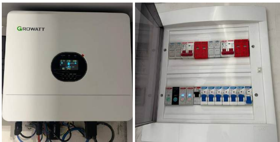
Рис. 2. Інвертор growatt 6000 і шафа керування
