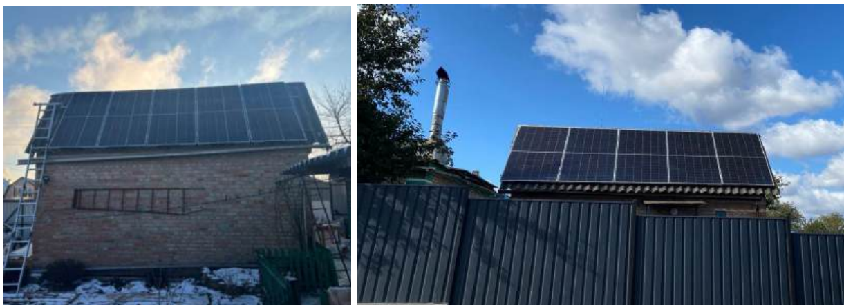
Рис. 1. Сонячна електростанція (батареї орієнтовані на захід і на схід)
